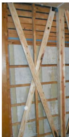
筋交いによる壁の補強
